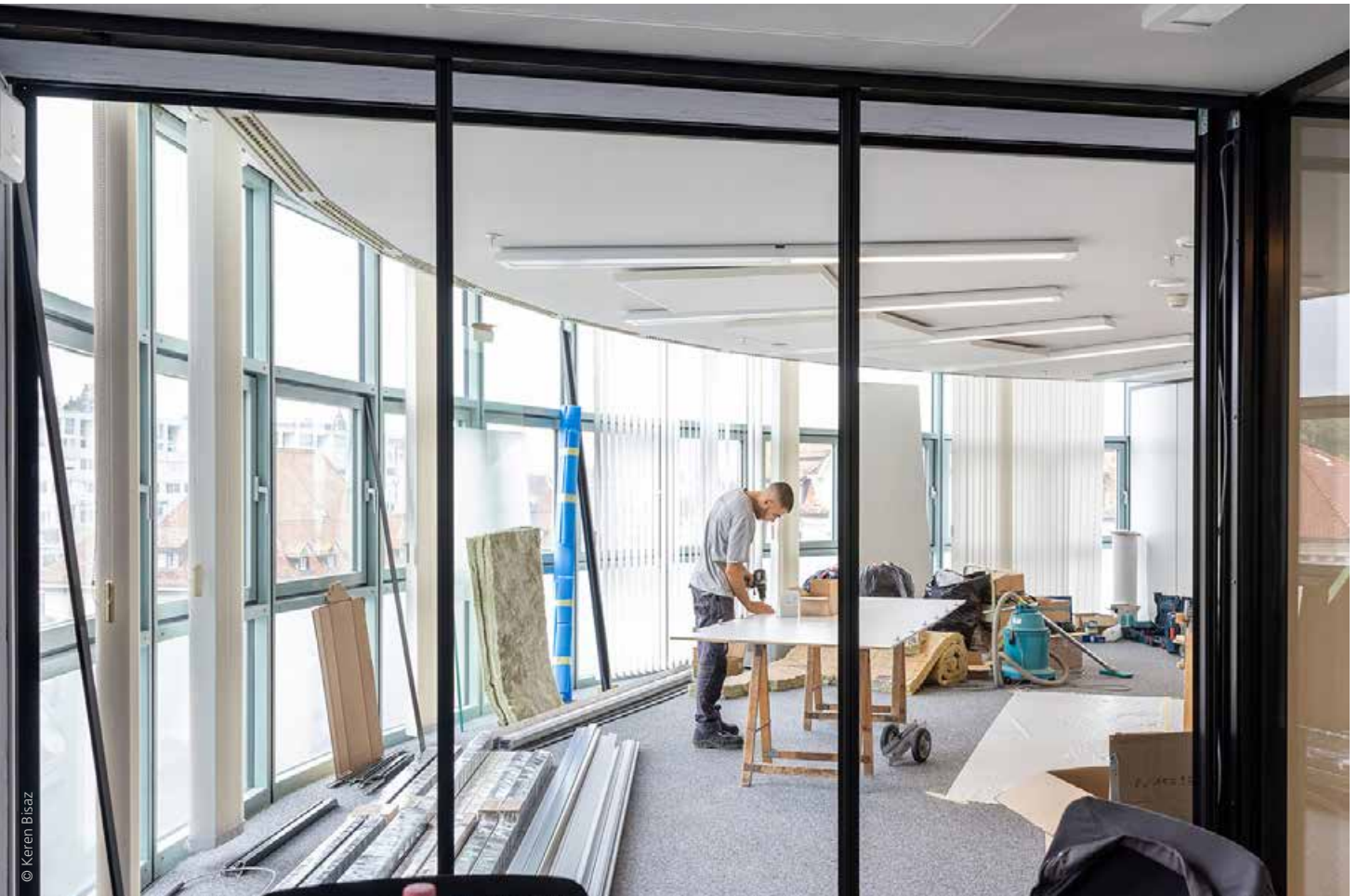
Réaménagement des bureaux de la Direction générale au Siège
