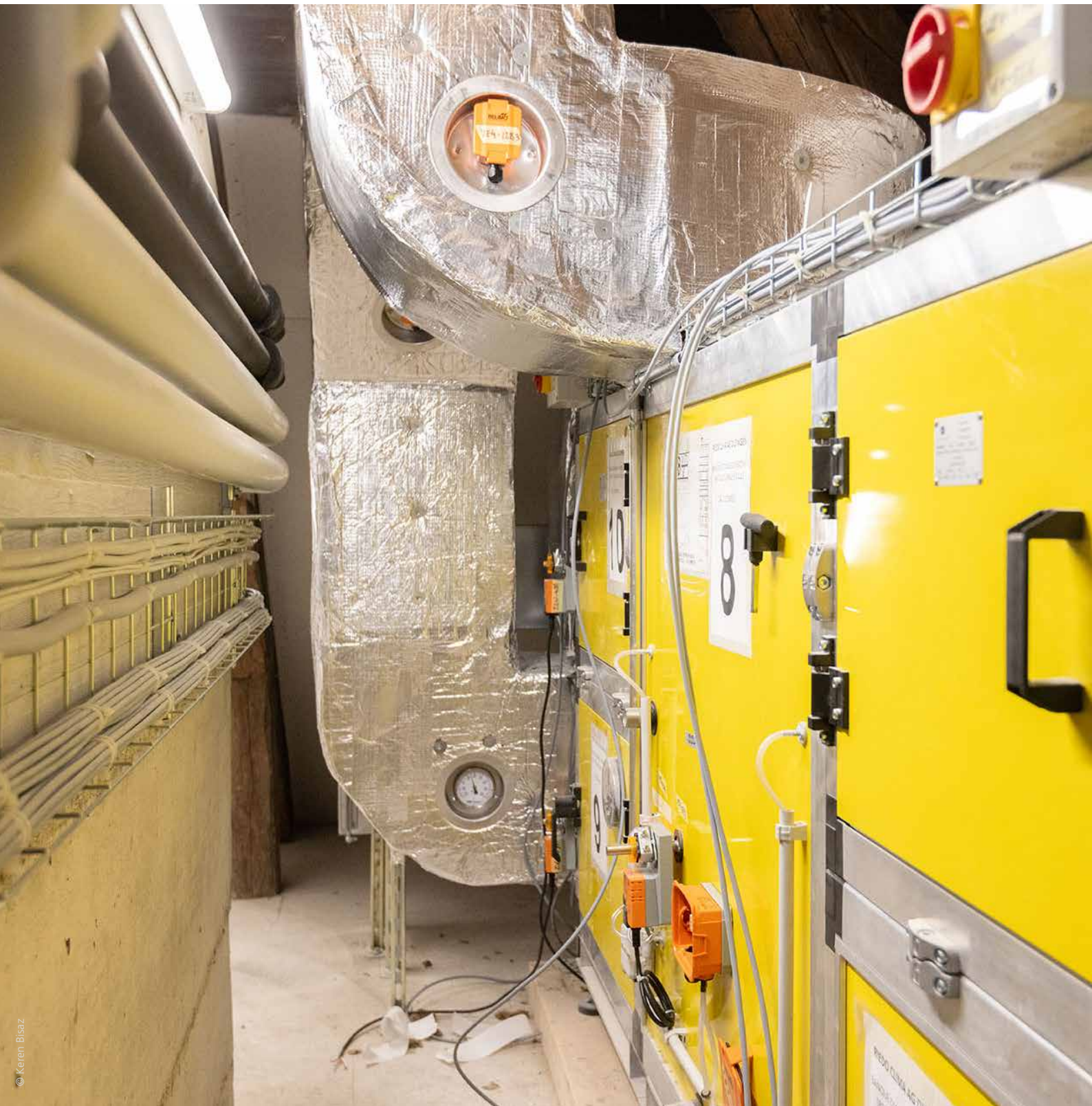
Rénovation des systèmes de chauffage et de ventilation à la succursale de Bulle, Place du Tilleul
