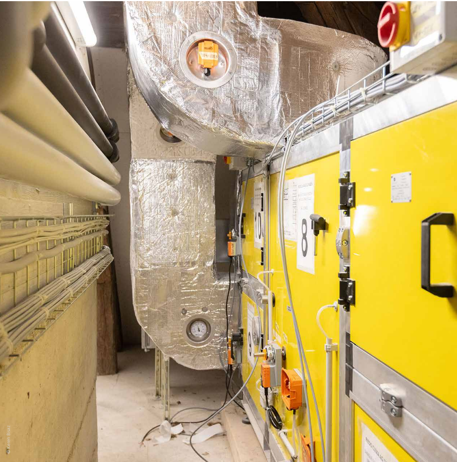
Erneuerung der Heizungs- und Belüftungssysteme in der Niederlassung Bulle, Place du Tilleul
