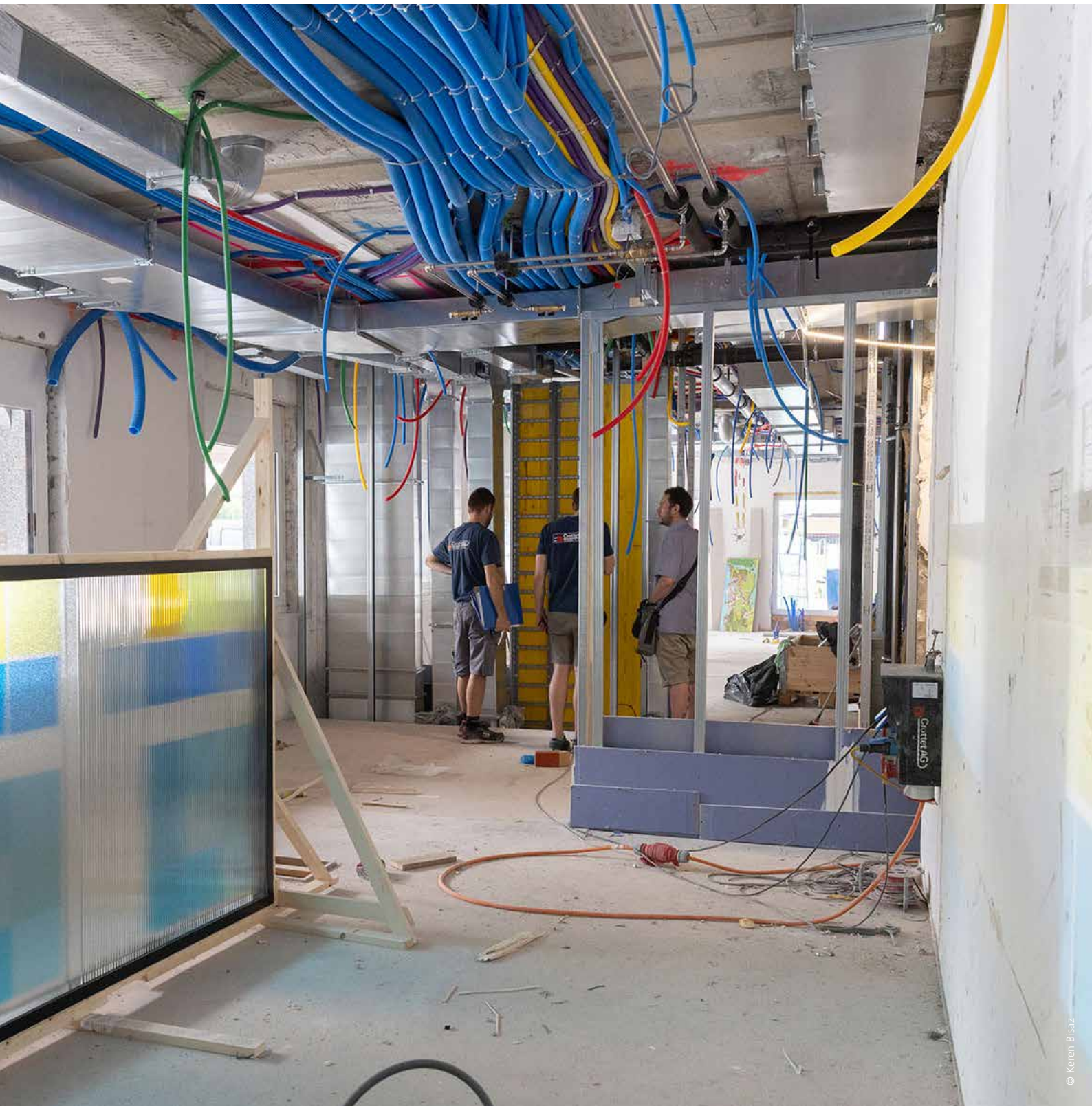
Renovierung der Niederlassung Düdingen
